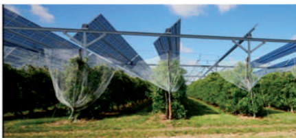
Enkel-as zonvolgsysteem met tweezijdig werkende panelen
