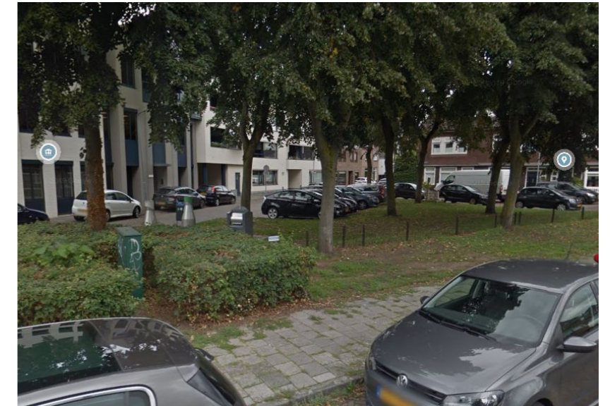
Gemaalkast, containers en HUP
