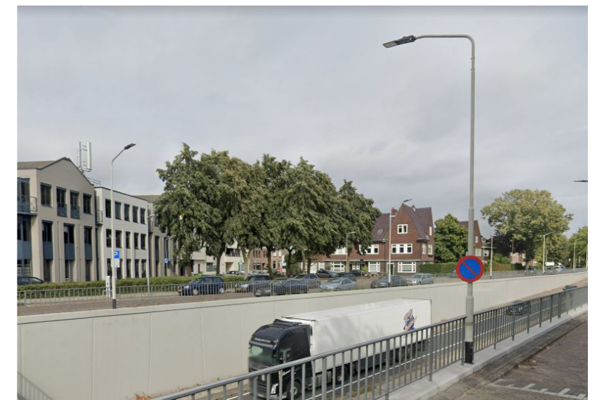
Hoge masten langs tunnelbak
