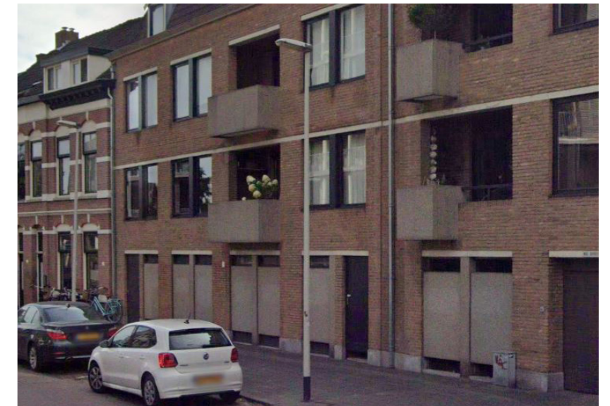
Standaard mast Prins-Hendrikstraat
